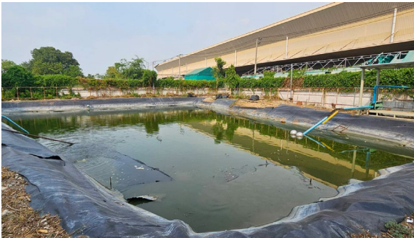
นำน้ำจากการบำบัดเติมสระน้ำด้านหน้าโรงงาน
