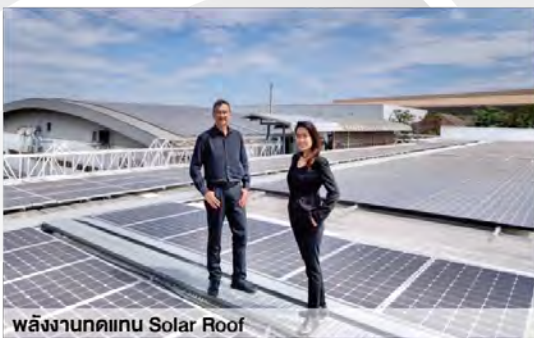
พลังงานทดแทน Solar Roof
