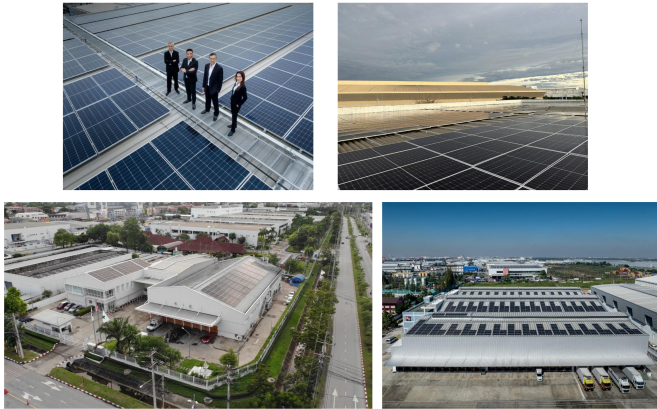
โครงการ S&P Solar rooftop
